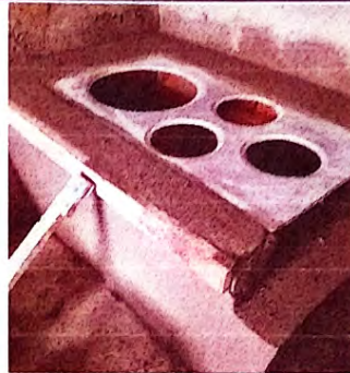
Foto 14 sustitucion de estufa rural
