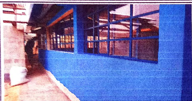
Foto 7: Sustrucion de canales pluviales
