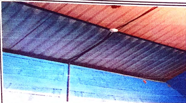
Foto 13: Reparacion de sistema electrico
