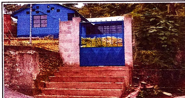
Foto 10: Reparacion de portones
