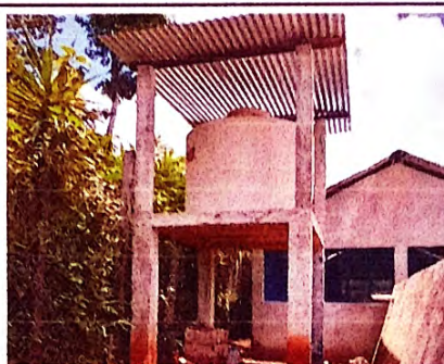
Foto 4: construcción de base para tinaco
