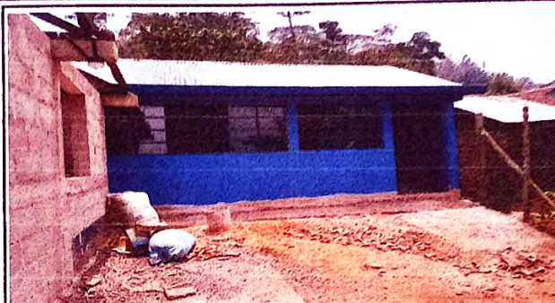
Foto 8: Susutitucion de canales pluviales
