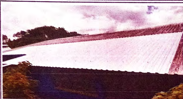
Foto 1: Reparación de cubierta de lámina a troqueladas
