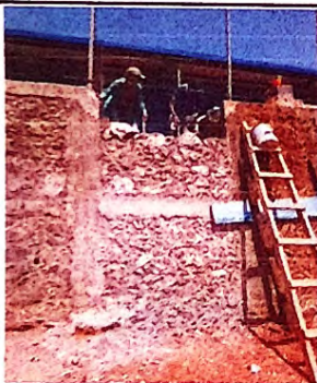
Foto 15 reparacion de muro de contencion
