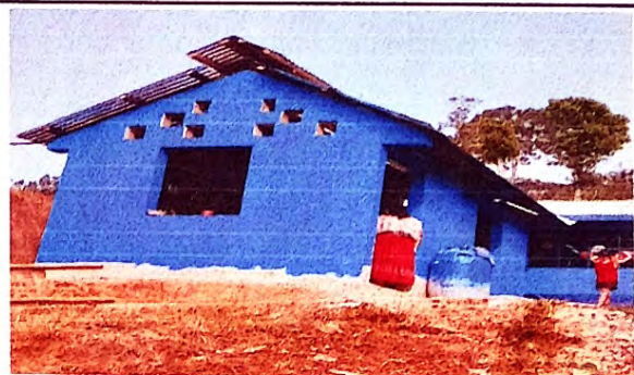
Foto 16: Reparacion de pared de cocina.
