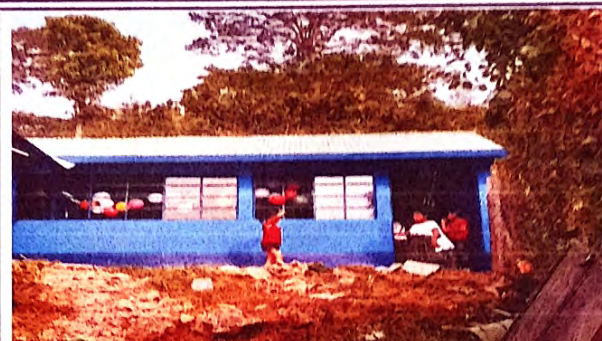
Foto 2: Sustitución de láminas sobre el aula de cuarto, quinto y sexto primaria.
