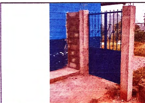
Foto 9: Reparacion de portones
